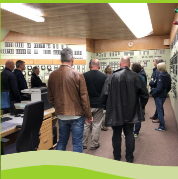
Leitzentrale des KKW Rheinsberg
